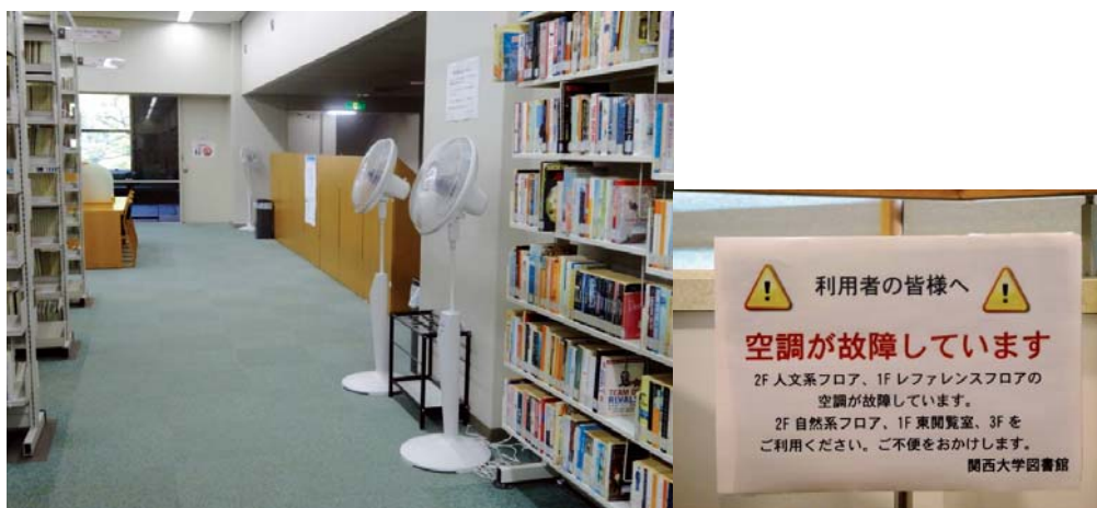
空調故障による応急措置 (2013.7)
