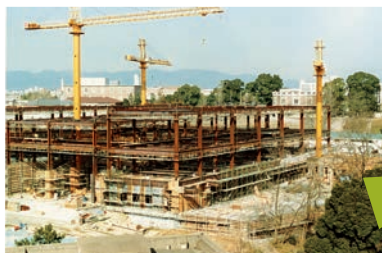
建設中の総合図書館
