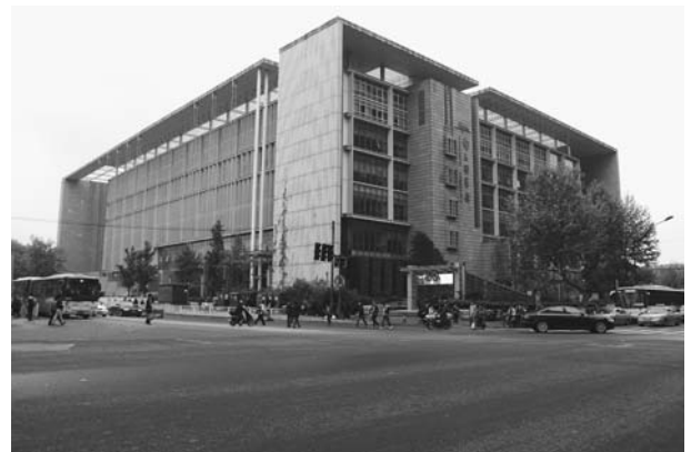
南京図書館西・南側外観
