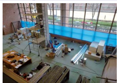
旧雑誌架スペース工事 (2015.2)
